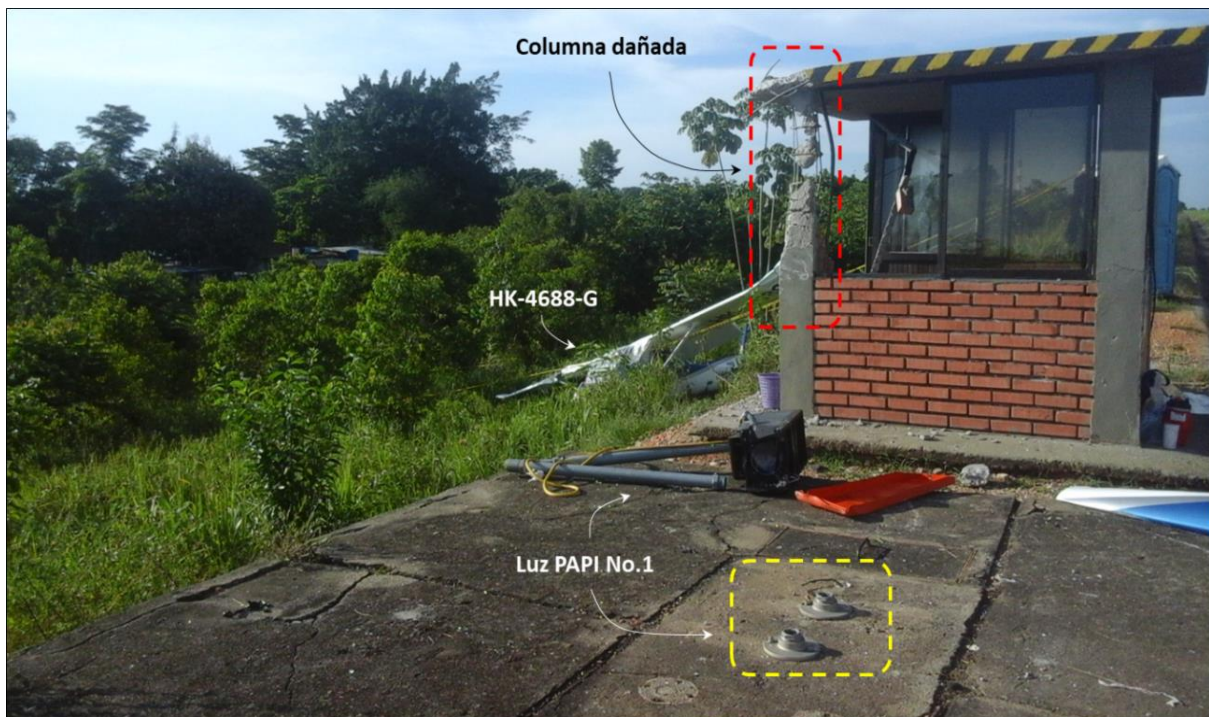
Fotografía No. 2: Daños presentados en la infraestructura aeroportuaria
